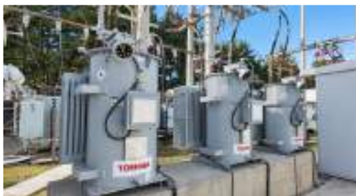
REGULADORES DE TENSION 7,6 Kv
