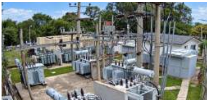
REGULADORES DE TENSION 7,6 Kv
