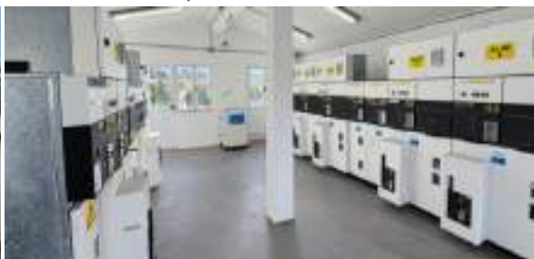
SALA DE CELDAS DE 13,2 kV
