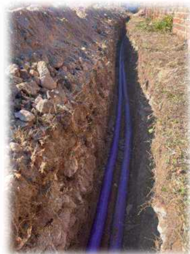
Nueva LSBT sobre calle Salta entre Chile y Complejo Bonna (Obra 11.4)
