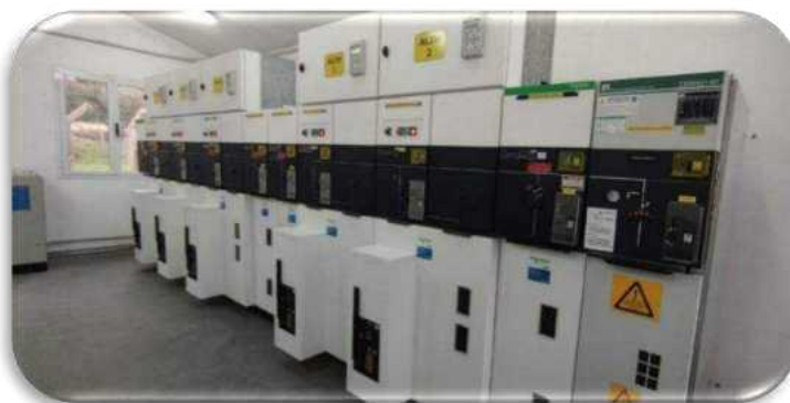
Parque de Rebaje EL PRADO 33/13,2kV (Playa de Maniobra y Celdas de 33/13,2 kV)
