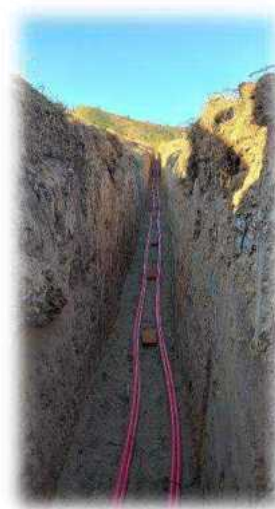
Construcción de LSMT Barrio Altos de Molvento (Obra 11.2)
