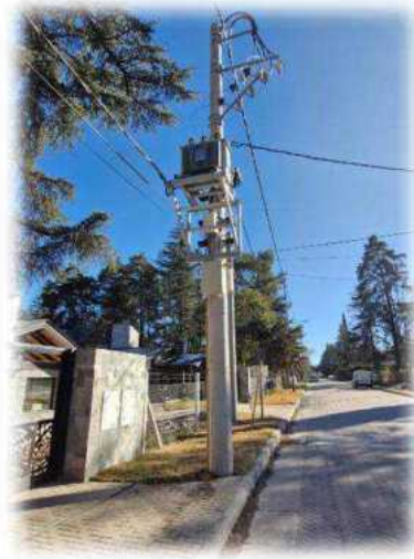
Nueva SET 13,2/0.38kV - 160 kVA en Av. Comechingones y Los Alerces (Obra 10.6)
