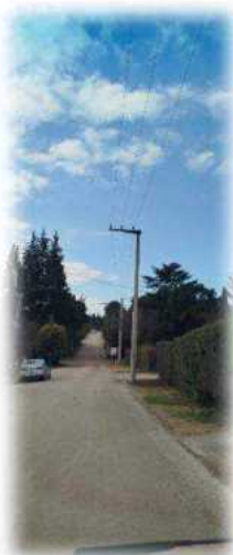
Nueva LAMT sobre calle Colombia entre Paraguay y Salta (Obra 11.4)
