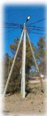
Instalación de postecillos con protección termomagnética y sistema de PAT para puestos y carpas
