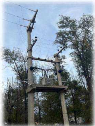
Nueva SET 13,2/0.38kV - 160kVA en calle Los Cisnes de Villa Castelar (Obra 10.1)
