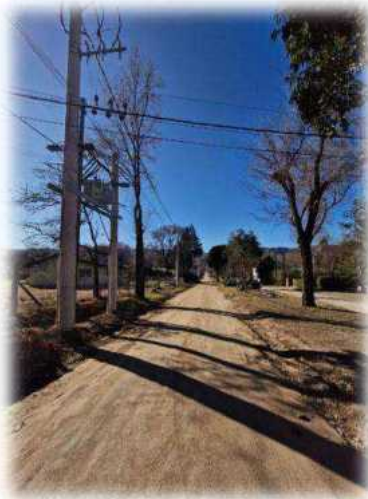
Nueva LAMT preensamblada sobre calle Trafal entre Ruta S-210 y L. Lacar en VGB (Obra 10.3)
