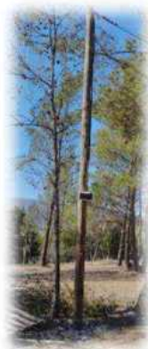
Instalación de postecillos con protección termomagnética y sistema de PAT para puestos y carpas
