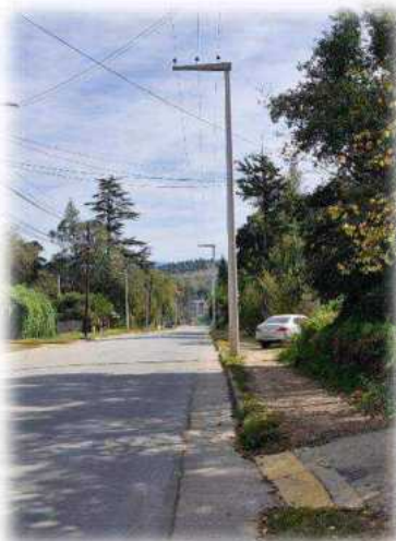
Nueva LAMT sobre calle Corrientes entre Formosa y Venezuela en VGB (Obra 10.2)
