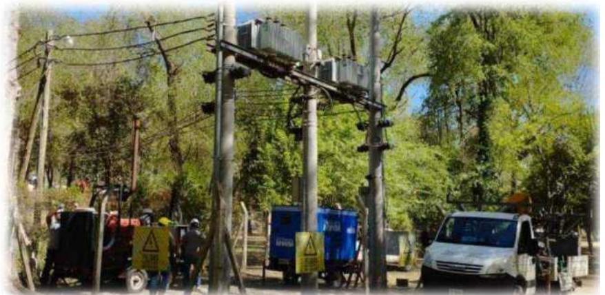
Mantenimiento integral SET Bosque de Los Pioneros 2x400kVA – Instalación de Grupos Electrogenos 315 kVA y 35 kVA
