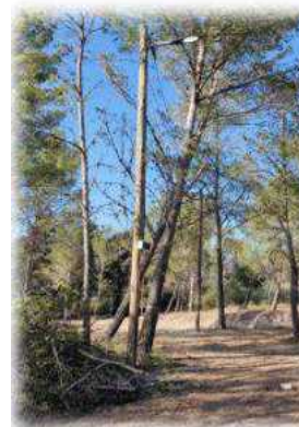
Instalación de postecillos con protección termomagnética y sistema de PAT para puestos y carpas
