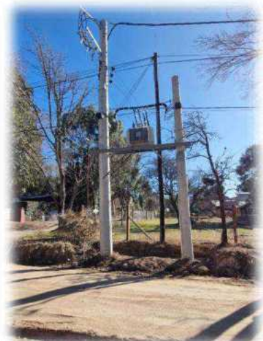
Nueva SET 13,2/0.38kV - 160 kVA en calle Trafal y Lago Lacar en VGB (Obra 10.3)
