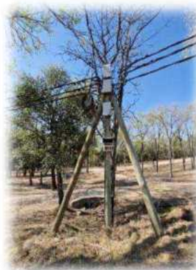
Instalación de postecillos con protección termomagnética y sistema de PAT para puestos y carpas
