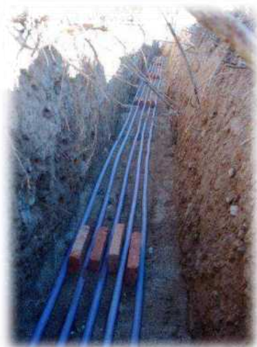
Construcción de LSBT Barrio Altos de Molvento (Obra 11.2)
