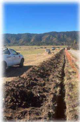
Tendido de nueva LSMT vinculación entre nuevas SET's de calle L. Mansilla (Obra 10.4)
