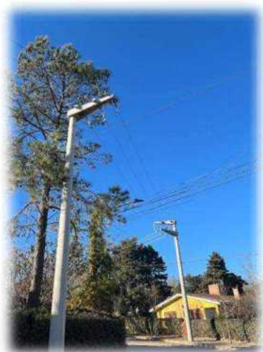
Nueva LAMT sobre calle Salta entre Colombia y Chile (Obra 11.4)
