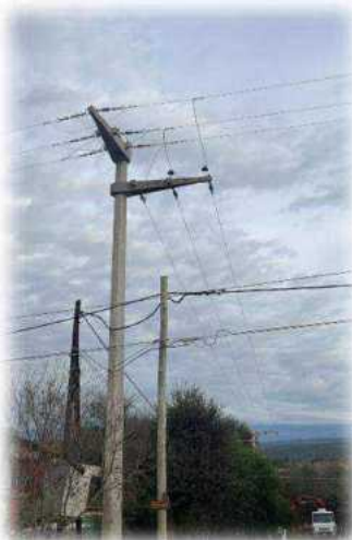
Inicio nueva LAMT sobre calle Los Cisnes desde Ruta 5 en Villa Castelar (Obra 10.1)
