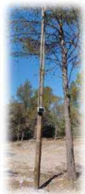
Instalación de postecillos con protección termomagnética y sistema de PAT para puestos y carpas
