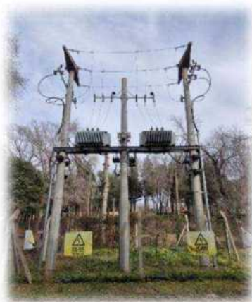
Mantenimiento integral SET Bosque de Los Pioneros 2x400kVA – Instalación de Grupos Electrogenos 315 kVA y 35 kVA
