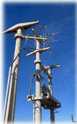
Inicio tendido nueva LSMT en SET N° 243 H. Boden hacia nuevas SET B. Bertone (Obra 10.4)
